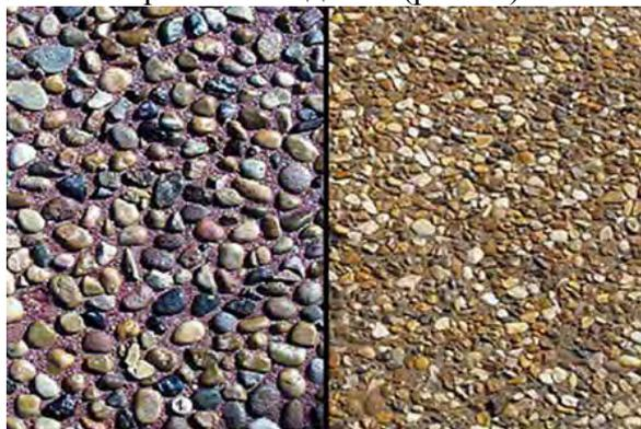
Рис. 6. Тротуарная плитка из декоративного бетона. Текстура «Морская галька»
