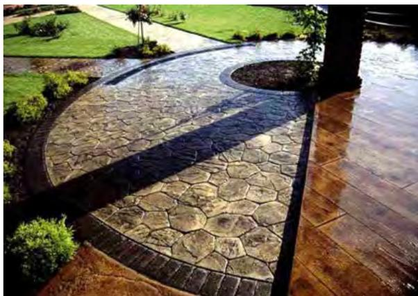
Рис. 5. Тротуарная плитка, выполненная из декоративного бетона. Имитация природного камня
